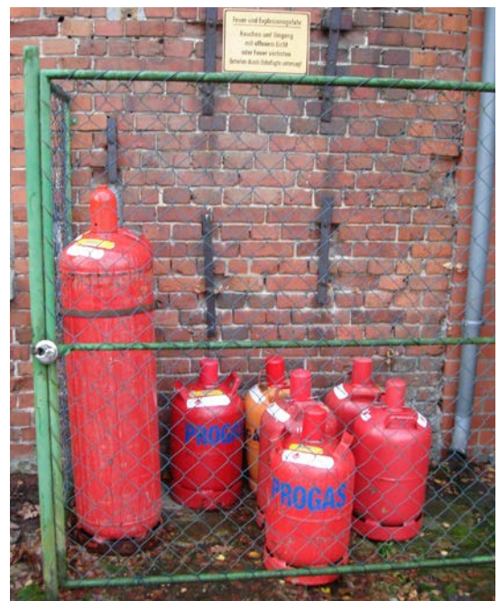
Abb. 8-2 Lagerung gefüllter Druckgasbehälter im Freien
