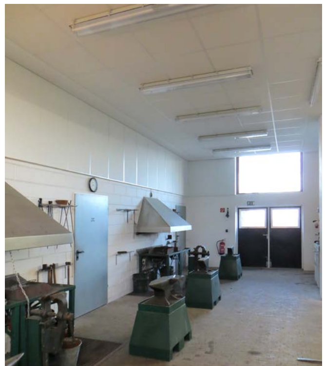
Abb. 3-3 Lärmgeminderte Decke in einer Schmiedewerkstatt
